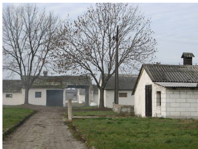
Fot.5. Płyty azbestowo-cementowe faliste na budynkach inwentarskich Aleksandrowie.
